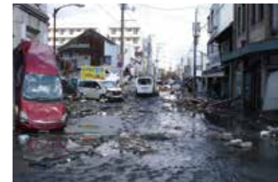
石巻市中央2丁目付近の被害状況
